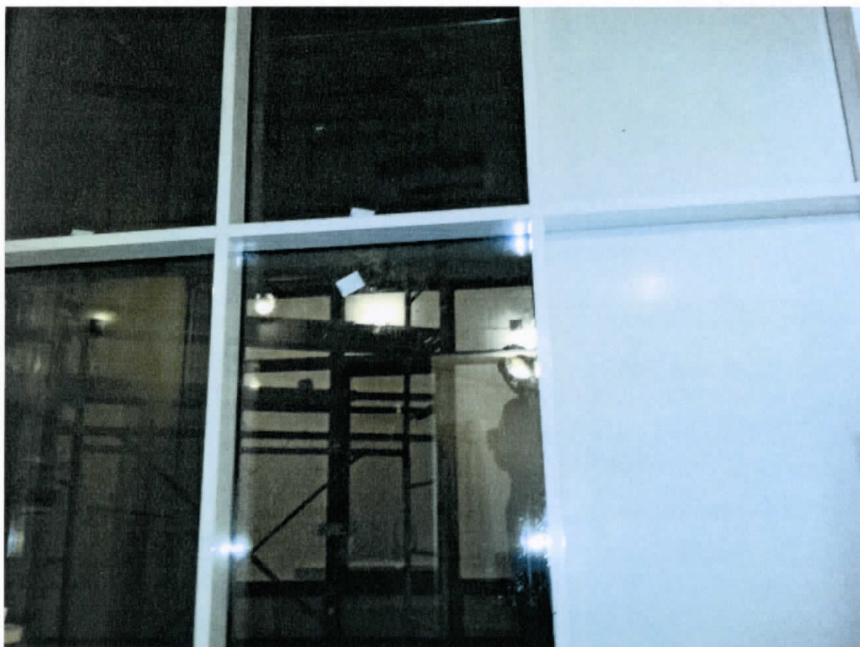
Рис.3. Внешний вид образца установленного в климатической камере КТК-2007
